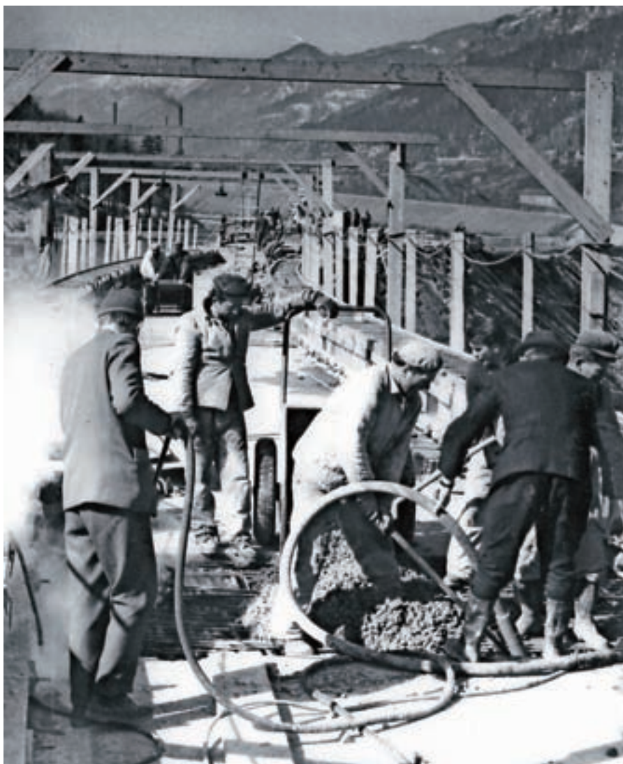
Gradnja nove valjarne na Koroški Beli, Jesenice, 2. 10. 1969 / Foto: Franc Perdan, GG, hrani Gorenjski muzej
